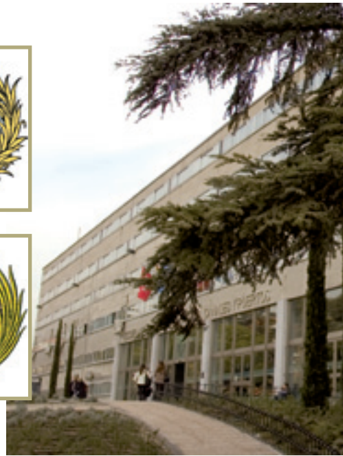
E.T.S.I. de Caminos, Canales y Puertos Fachada
